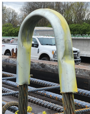
Crushed conduit
