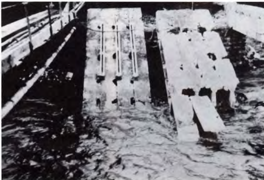
Fig. 12. Collapsed Ynys-y-Gwas Bridge.
