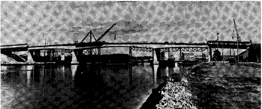
Fig. 13—Silverwater Bridge, Sydney, Australia
