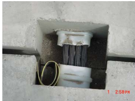
Fig. 10 Longitudinal Post-Tensioning Strand
