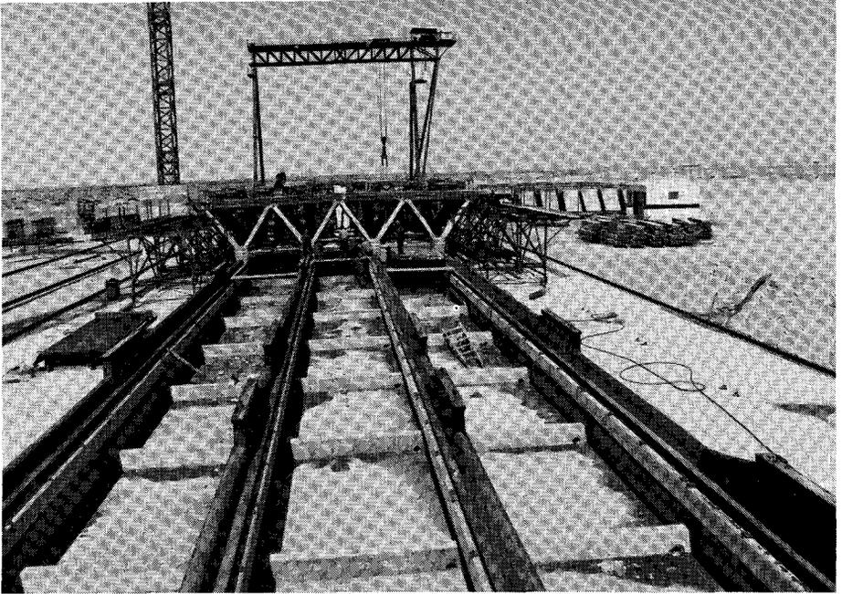
Fig. 23. Longitudinal rib soffit forms (courtesy of Bouygues).
