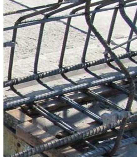
Fig. 14: Stirrups in cage
