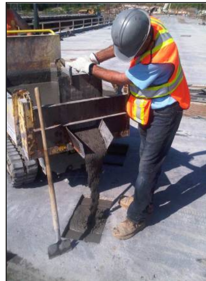
Fig. 8: Pouring a UHPC joint
