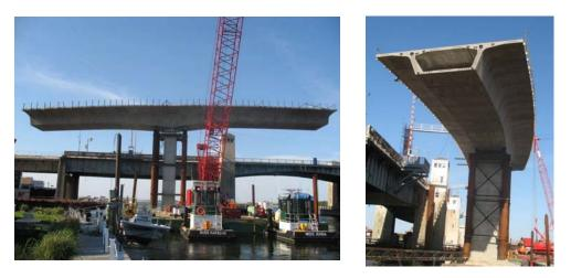
Fig. 9 Pier 3 Cantilever
