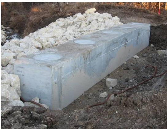
a. Precast abutment
