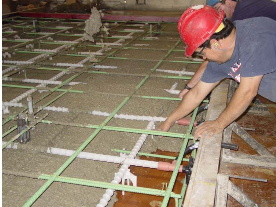
Fig. 9 Pouring of Panel 3A
